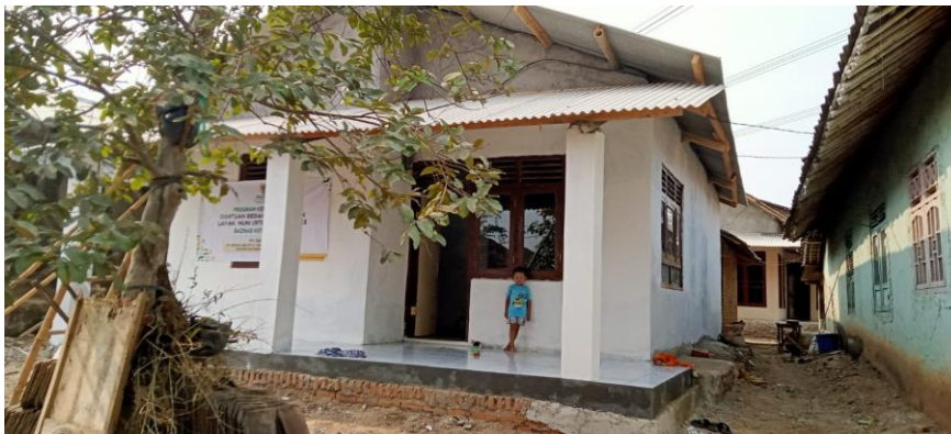
Kedaaan rumah Ibu Saroh setelah selesai pelaksanaan program bedah Rumah Tidak Layak Huni BAZNAS Kota Serang
